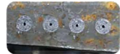
\*Nettoyage des contours du perçage après avoir réalisé l'ouverture.
